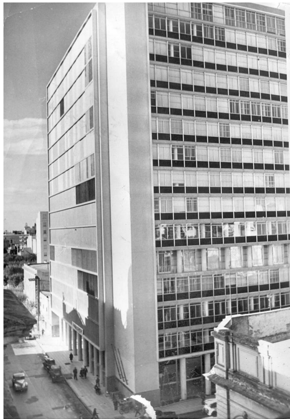
Edificio del Banco de la provincia de Buenos Aires. Fotografía del estudio “La Valle” propiedad de Roque Martínez. Fuente: Fotos de Familia.
